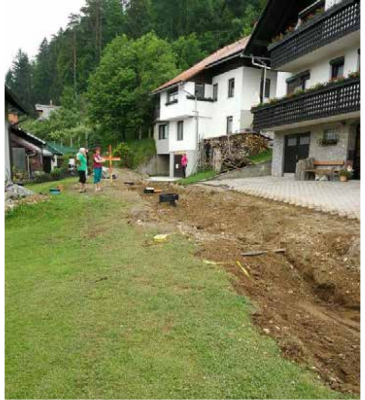
Gradbena dela – sekundarna kanalizacija Gortina
