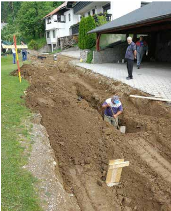
Gradbena dela – sekundarna kanalizacija Gortina
