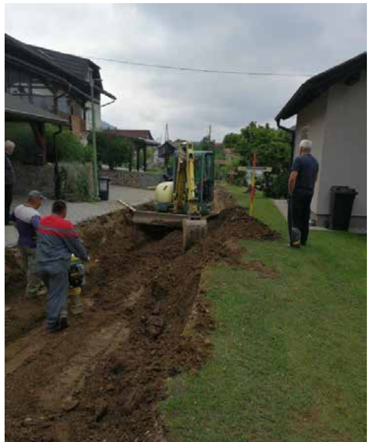
Gradbena dela – sekundarna kanalizacija Gortina
