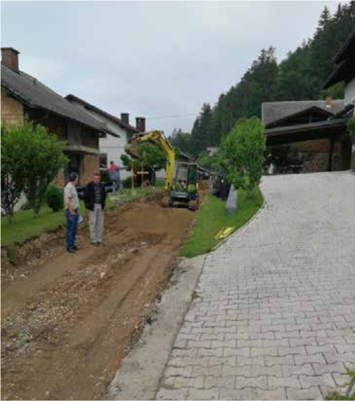
Gradbena dela – sekundarna kanalizacija Gortina
